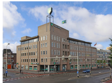
Kantoorgebouw met huurder Gasterra
